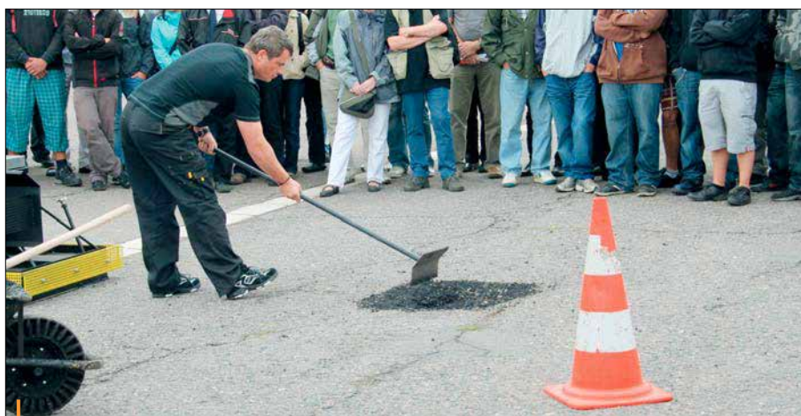
Chybějící materiál se do výtluku přidává s potřebným navýšením
