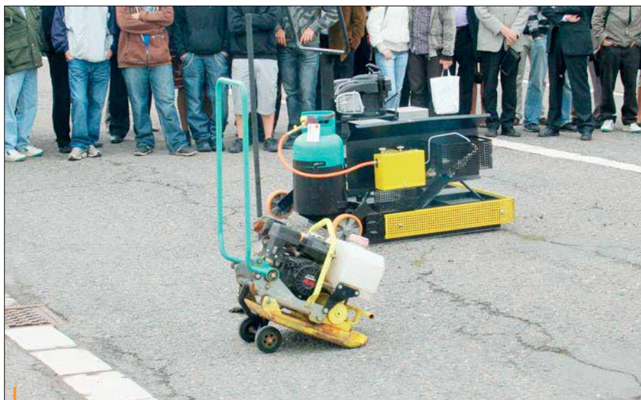
Nahřívací termodynamická deska THD je určena k rozehtání asfaltového povrchu v místě opravy
