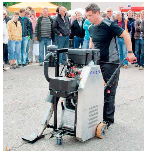
Vysokotlaký nahříváč KOMP SL spáru vyčistí a zároveň nahřeje. Tím je zabezpečeno kvalitní spojení zálivkové hmoty s konstrukcí vozovky
