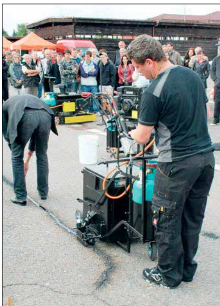
Zálivkový kotlík KK 50 aplikuje zálivkové hmoty do přímých i divokých trhlin
